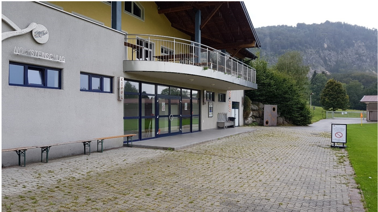
Abbildung 7: Umkleiden, Duschen und WCs im Untergeschoss
